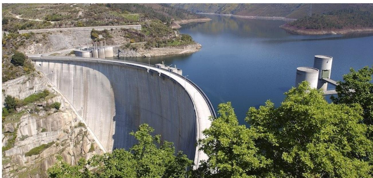
Construção de uma barragem em betão, do tipo de abóbada de dupla curvatura, com 110 metros de altura, 21 metros de espessura e 297 metros de desenvolvimento do coroamento. Situa-se no rio Lima em pleno Parque Nacional da Peneda-Gerês, no norte de Portugal. Pela sua dimensão e características técnicas, é um marco na história das grandes obras realizadas pelo Grupo.
